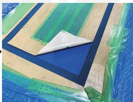
ラインを手作業で丁寧に染め、乾燥させます。乾いた後に型枠と養生を取り除きます。
