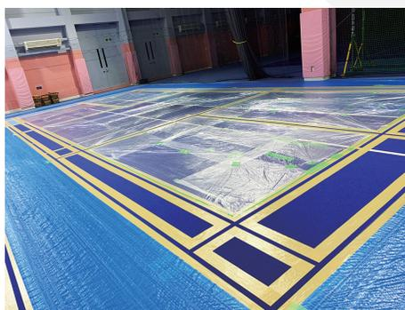
カーペットコートのテニスコート上に、新たに入れるラインに沿って型枠を作ります。周りに染料が付着しないよう、養生は丁寧にいきます。
